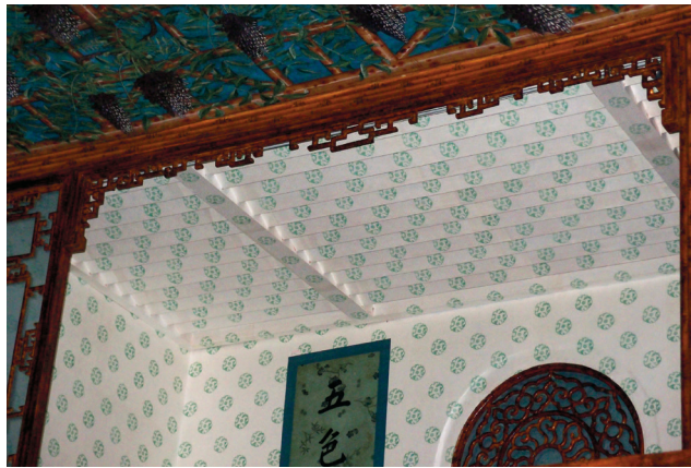
图3. 倦勤斋室内环境控制系统通风口（作者摄）
